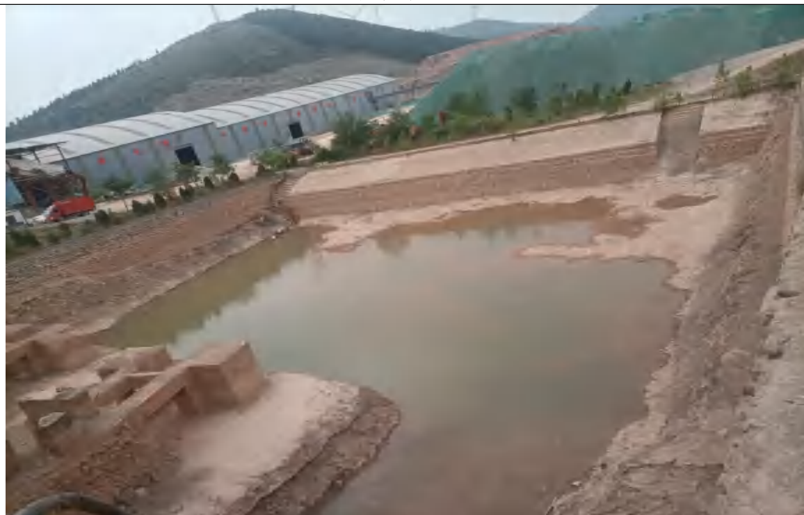
矿井水蓄水池
